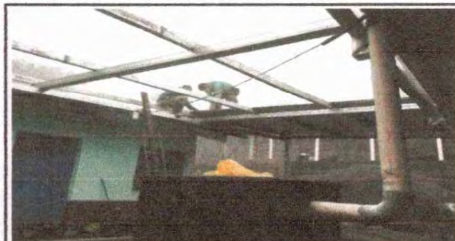
Foto 10: CUBIERTA DE LAMINAS EN EL CORREDOR DE AULAS
