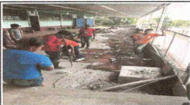
Foto 1: EN PROCESO DE SUSTITUCION DEL PISO DE TORTA DE CEMENTO
