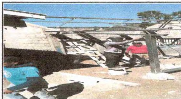
Foto 16: INSTALANDO ESTRUCTURA DE TECHO DE COCINA
