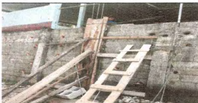
Foto 6: COLOCANDO COLUMNAS DE SOPORTE DEL MURO DE CONTENCIÓN
