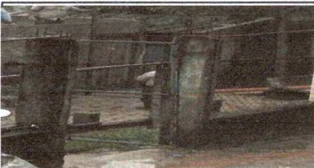
Foto 15: COLOCACION DE COLUMNAS DE SOPORTE
