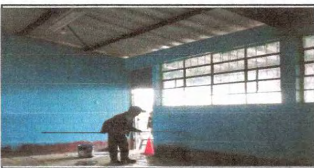
Foto 11: PINTANDO MUROS INTERIORES
