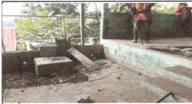
Foto 2: ES LA PARTE DE ARRIBA POR DONDE SE COLOCO LA COLUMNA DE SOPORTE
