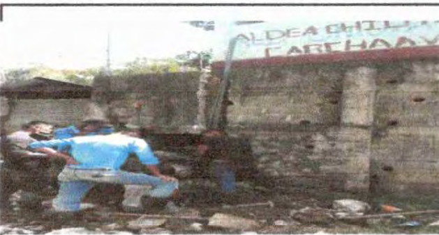
Foto 3: COLOCACION DE COLUMNAS DE SOPORTE
