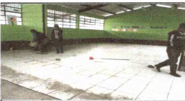
Foto 12: SUSTITUYENDO PISO DE CONCRETO A PISO CERAMICO
