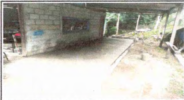
Foto 13: COLOCANDO TORTA DE CEMENTO EN EL CORREDOR DE COCINA
