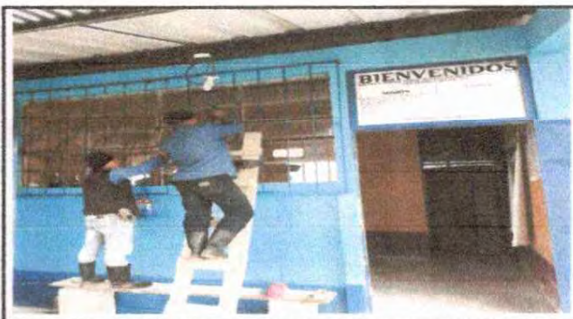
Foto 10: PINTANDO PAREDES Y BALCONES
