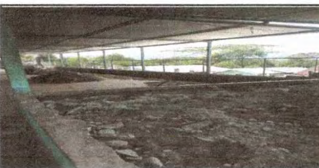
Foto 11: COMPACTANDO LA TIERRA PREVIO A LA SUSTITUCION DE TORTA DE CEMENTO
