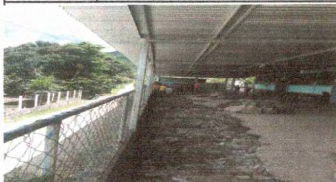
Foto 7: EN PROCESO DE SUSTITUCION DEL PISO DE TORTA DE CEMENTO
